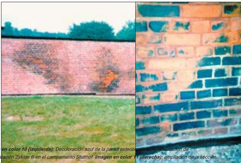
**Imagen en color 10 (izquierda):** Decoloración azul de la pared exterior de la instalación de desinfección Zyklon B en el campamento Stutthof. **Imagen en color 11 (derecha):** ampliación de la sección.
